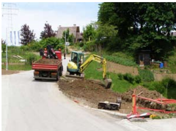
gradnja novih parkirišč
