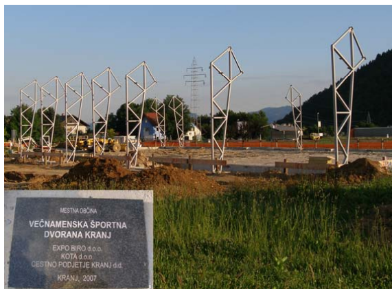
temeljni kamen in gradbišče – (foto M.L.Božič)
